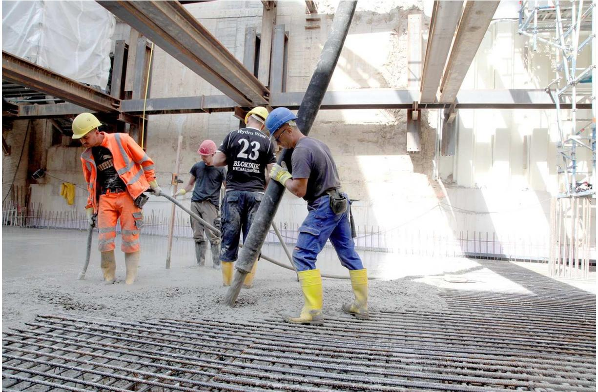
Für das Fundament wird die stählerne Bewehrung sorgfältig mit Beton gefüllt und verdichtet, damit keine Hohlräume entstehen. Foto: Sparkasse Bochum
