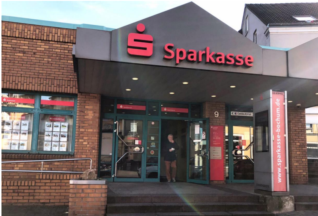
Die Sparkasse Bochum verlässt zum Jahresende das Gebäude an der Hans-Sachs-Straße 9. Foto: Sparkasse Bochum
